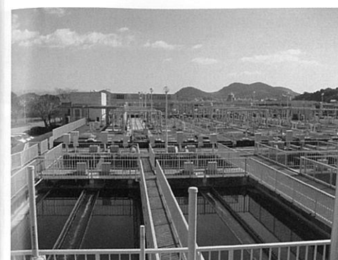
最初沈殿池、生物反応槽、最終沈殿池
