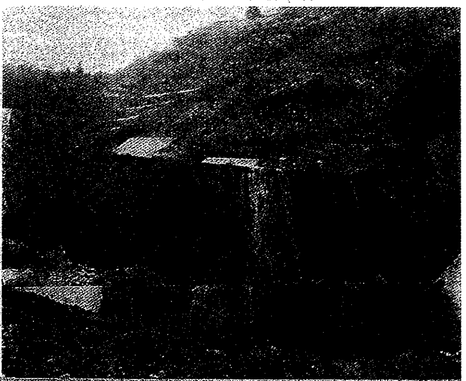
化石谷附近よりみる溪間工事 上流部に於ける練積堰堤
