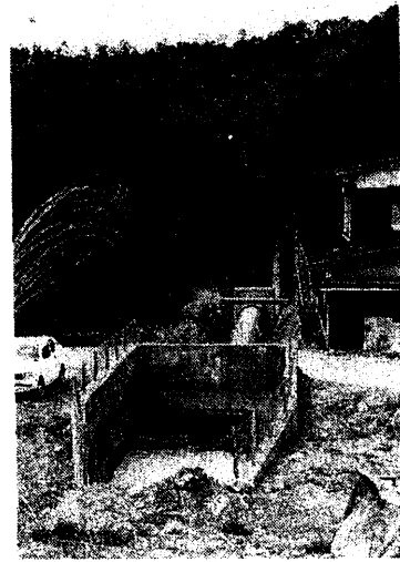
山腹を貫通して松山に至る 北部幹線水路
