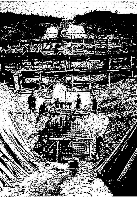
斜樋泥吐ゲート設置実況
