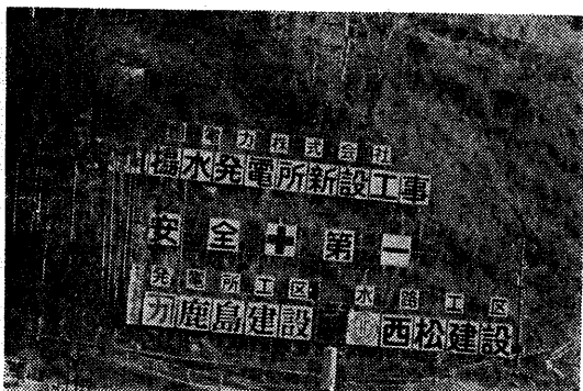
本川揚水発電所工事中
