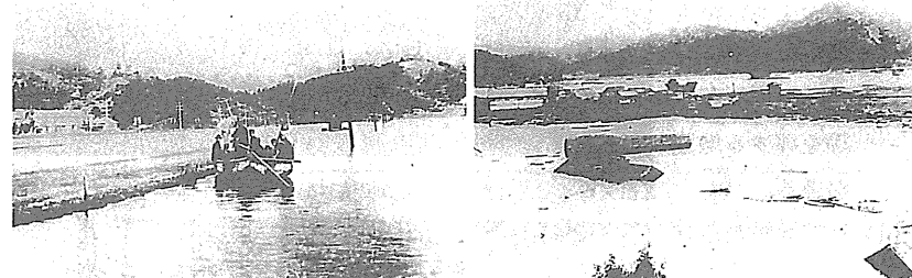
南海地震津波による須崎市の被害状況①堤防が決壊し泥の海となった多ノ郷地区②国道56号線大間付近
