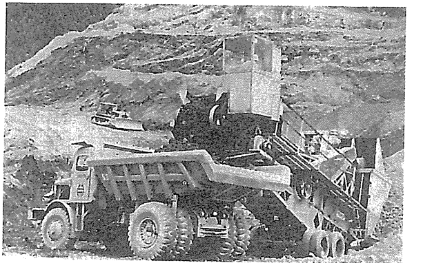
ダム建設に活躍した大型機械
