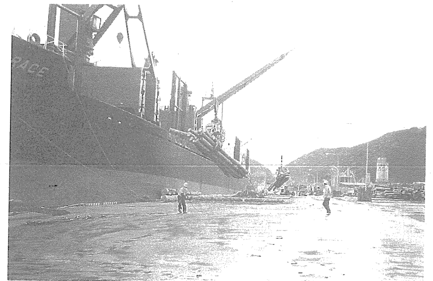
完成した須崎港1万5000t岸壁。外国船から木材が陸揚げされている
