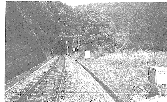
ループ式の第1川奥トンネルの入り口
