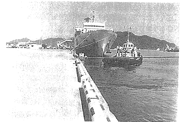
急増する船舶で新港の整備が急がれた高知港
