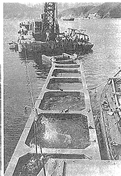
須崎港新岸壁工事に使われるコンクリートブロックの据え付け
