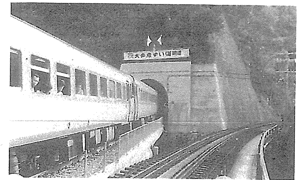
難工事のすえ、開通した四国最長の大歩危トンネル
