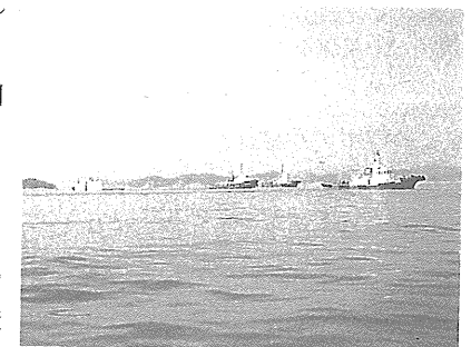
曳航中の長大ケーソン
