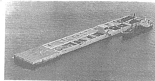
中詰め砂投入時の長大ケーソン
