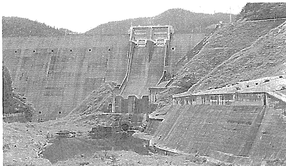
穴内川ダム、四国電力の大森ダムに次ぐ中空重式コンクリートダム(1964年7月完成)
