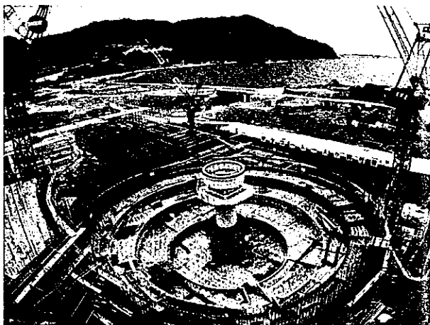
基礎工事が進む伊方発電所1号機 (昭和48年)
