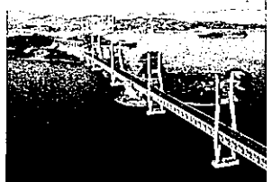
香川県側から岡山県側を望む開通直前の瀬戸大橋
