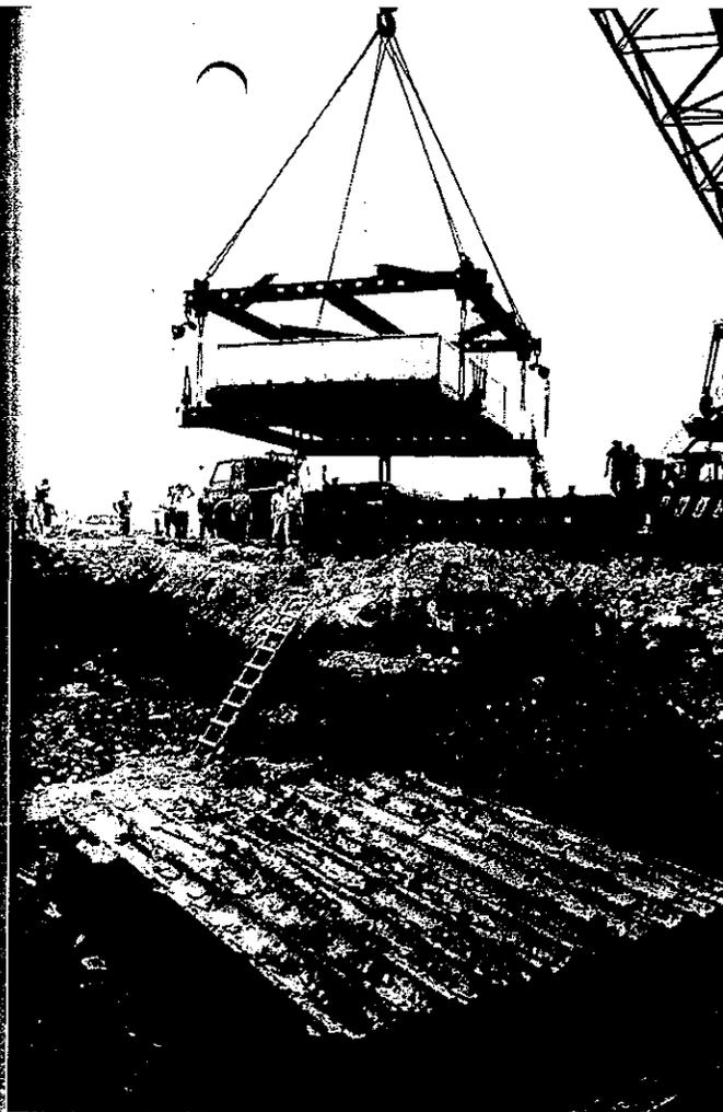
田村遺跡群の発掘調査で出てきた弥生時代の水田跡の一部を鋼管とコンクリートの箱詰めにし、永久保存のため移設した。1983年6月6日
