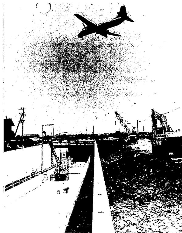
県道前浜一植野線の地下道化工事。新滑走路下をトンネルでくぐり、取り付け道路部分を含め延長約1,000mある。1983年（昭和58）7月
