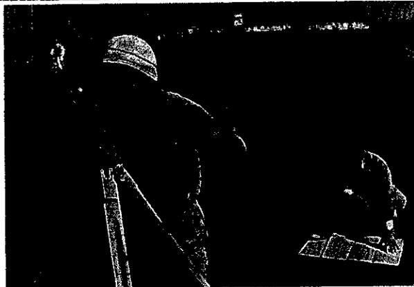
▷滑走路5cmかさ上げ工事のための測量
