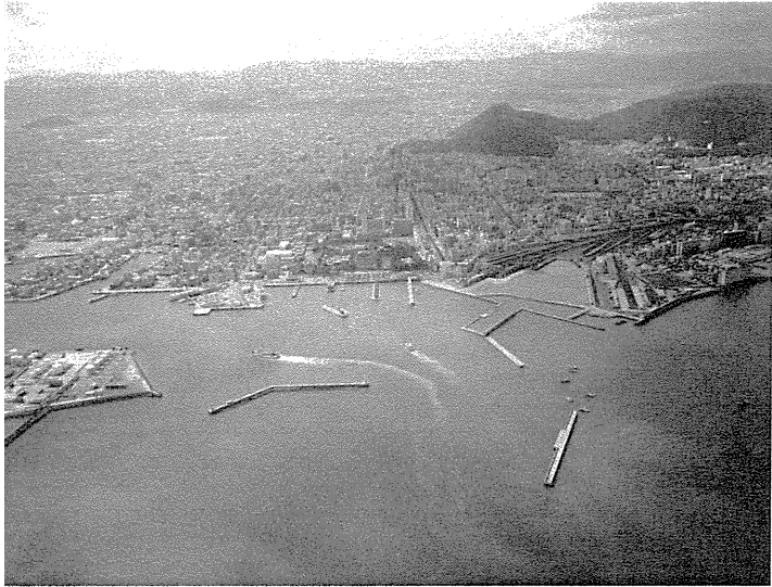
写真5 高松港全景（工事中）
