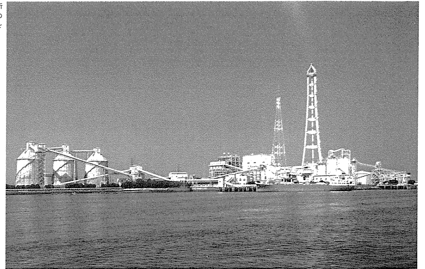
写真5 西条発電所 （1万3千tの 貯炭サイロを 3基設置）
