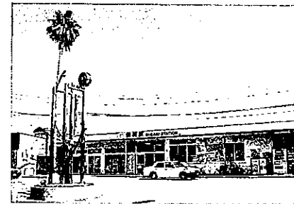
須崎駅前ロータリーとシンボル塔。駅舎の向かって左側が郵便局
