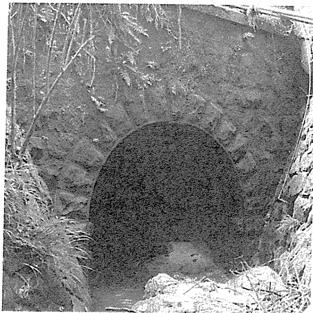
上流側の坑口
