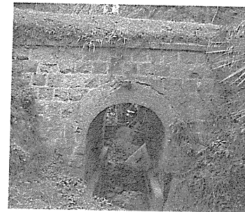
米津地区拱渠 (大正7年、大洲市)
