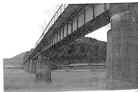
肱川橋梁(昭和11年9月、大洲市)
