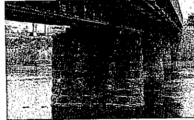
柞田川橋梁橋脚
