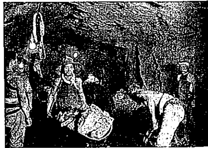
戸川口での掘削状況（鉄道省岡山工事建設事務所1929より）
