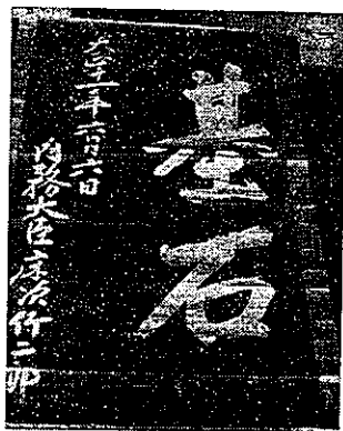
大正11年、県に移管内務省の手で工事がおこなわれた
