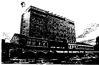
ホテルも合築した6階建ての宇和島駅ビル
