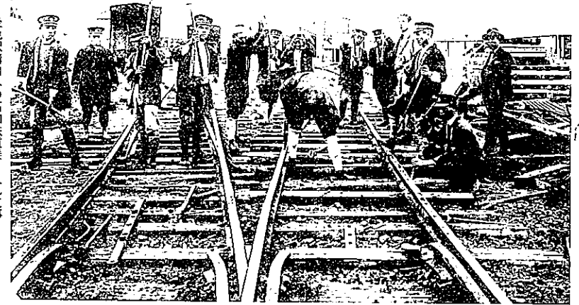
後免駅構内への高知鉄道乗り入れ工事
