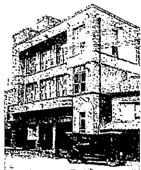
堺町に昭和2年オープンした初めてのエレベーター付「野村デパート」
