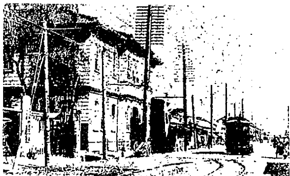
本町高知警察署左端電柱の横前にあったサイジング(右のカーブ)単線であったため、ここで電車は行き違いをしていた(中央は高知郵便局)
