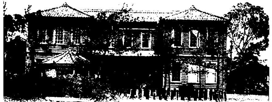
讃岐鉄道本社（2階）と多度津駅正面
