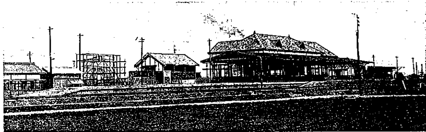
開業直前の今治駅（祝賀式のゲートを製作中）
