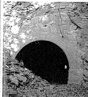
大越トンネル
