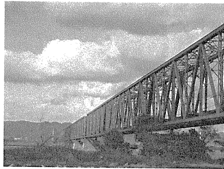
吉野川橋梁・下路式単純ワーレントラス
