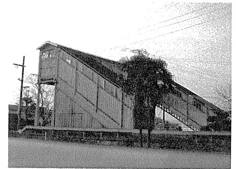
石井駅 跨線橋
