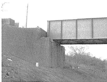
中路式プレートガーダ橋
