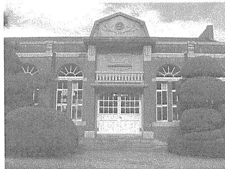
【写 3-9】 佐古配水場・ポンプ棟(大正15年)
