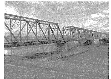
【写 3-6】 高徳線吉野川橋梁（昭和8年）
