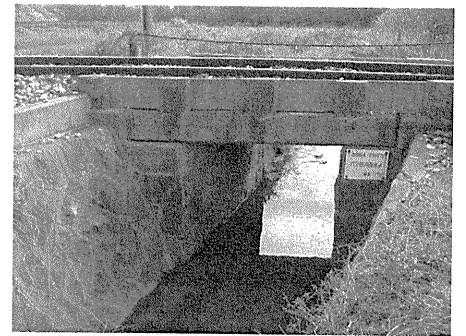
バラ谷川函渠
