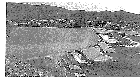
正保年間(1644~1648)に野中兼山によって造られた山田堰
