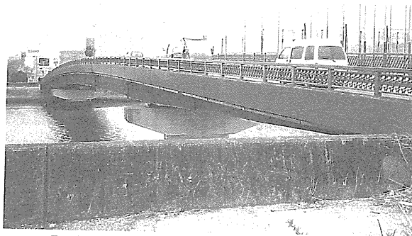
195号の新しい「葛島橋」。すぐ下流の電車軌道橋と国道55号の「新葛島橋」の橋脚位置の並び具合から計画上無理な条件となった。技術の粋を集め、特に両橋端部の桁高の低さはナイフエッジのようで、特徴の一つ
