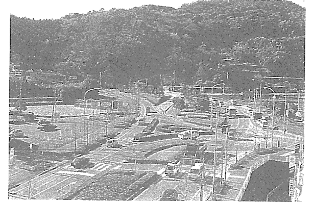
土佐道路荒倉トンネルの北口
