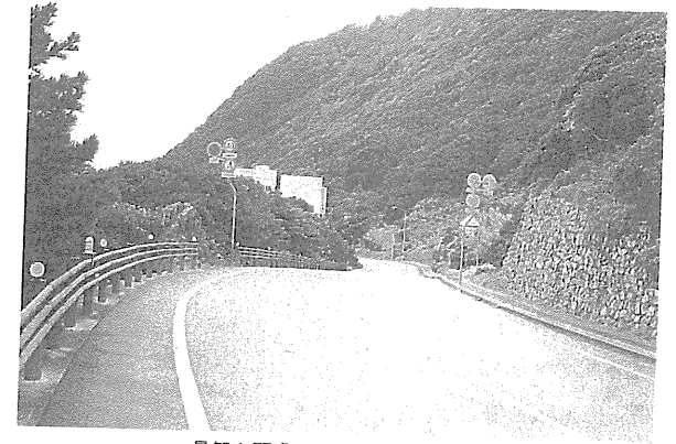
景観を配慮した室戸岬改良工事
