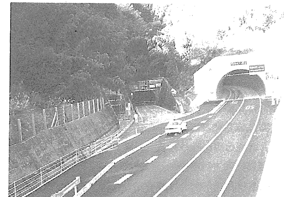
56号新旧の新名古屋トンネル
