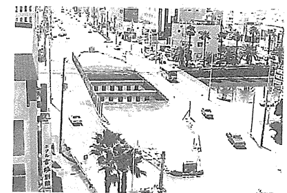
上部工を工事中的高知橋
