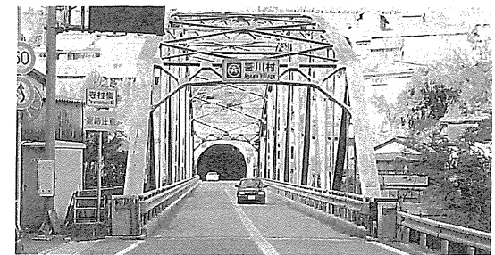
寺村トンネル高知側坑口と寺村橋
