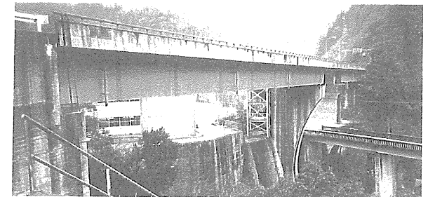
吾北村土居の土居大橋。国道194号吾北村土居の2つの鋼橋の中間は鉄筋コンクリートの門型ラーメン橋台で、この下を村道がくぐる。門型ラーメンの手前側の壁は、河川に突き出ることが河川管理上許されないことから橋の技術者の見せた意地の形。これにくっつけている鉄塔状のものは通学の学童に便を図った階段工
