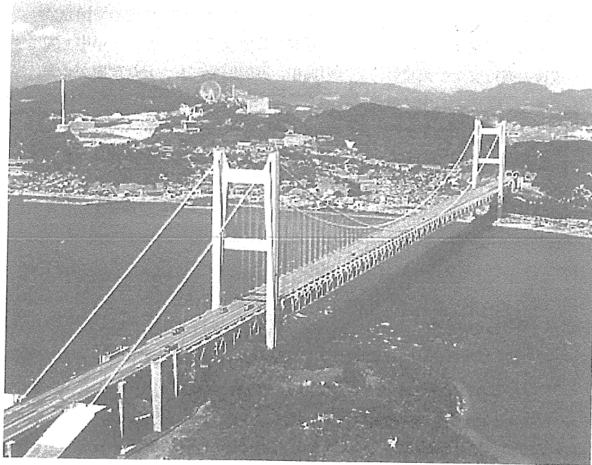
下津井瀬戸大橋
