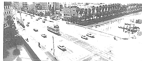
1963年ごろの高知橋、1962年12月載荷試験による応力測定の結果、まだまだ使えることが判明していた
