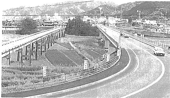
国道33号越知町坂折川に架かる新旧の越知橋。旧橋の市街地寄りのタイプは、ポニートラス橋で、今では県下でも数少ない
