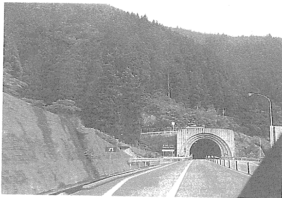
四国最長の道路トンネル笹ヶ峰トンネル(川之江側)
