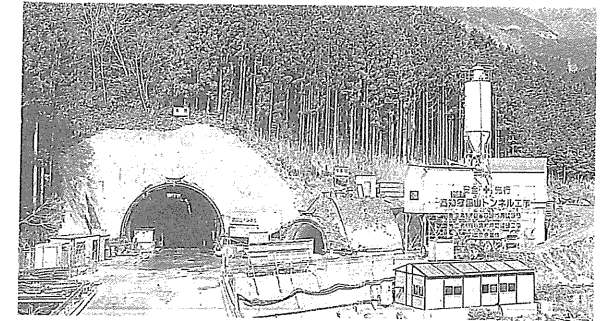
工事中の寒風山トンネル（高知県側）
