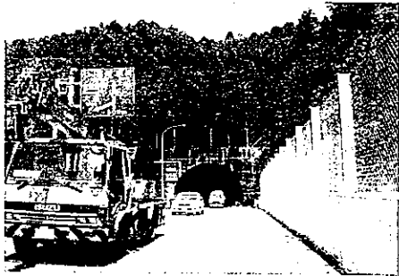
新窪川トンネル
