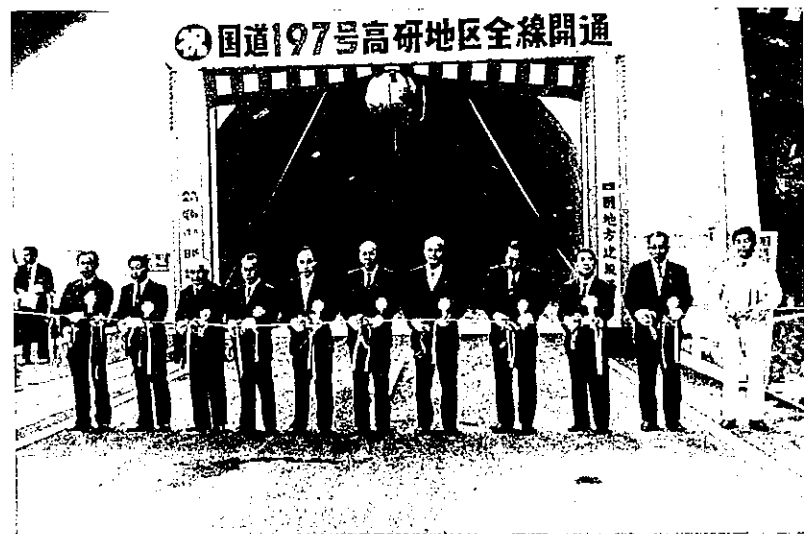
国道197号 高研地区全線開通
