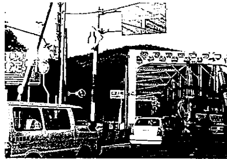
仁淀川橋全景 調査番号409011
