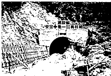
写真43 国道56号線内海トンネルの工事
