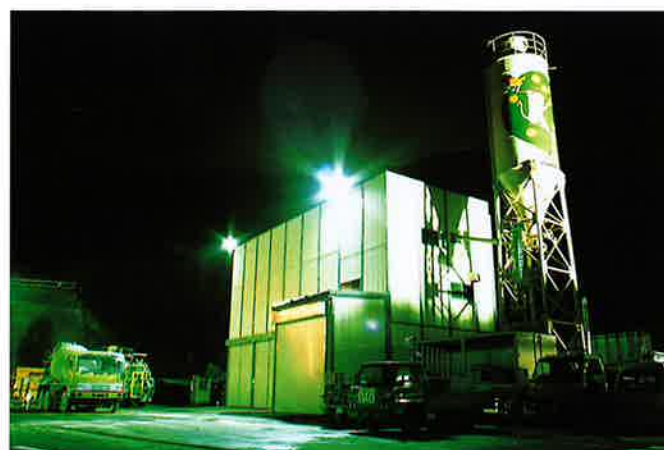
写5. 吹付コンクリートプラント (トラックミキサ室防音型)
