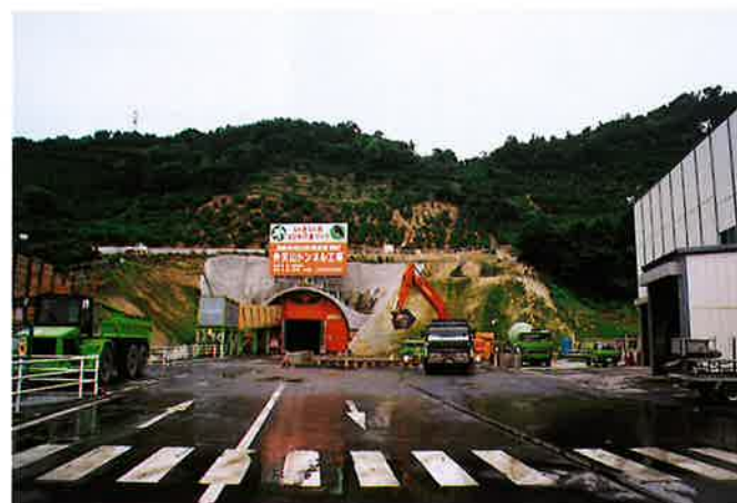
写3. 仮設ヤード全景 (防塵舗装)
