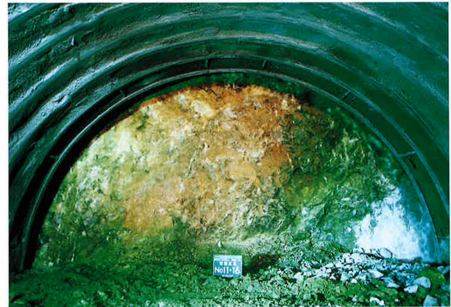
写1. 上部半断面切羽(地質、塩基性ホルンフェルス)
