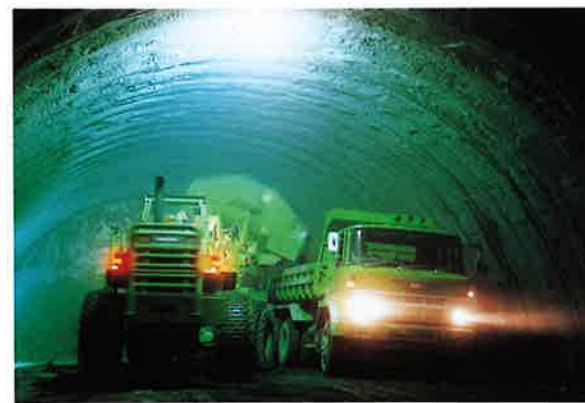
写11. ずり積み状況
