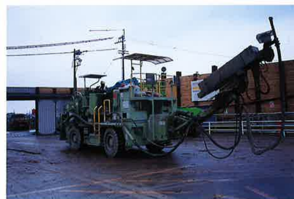
写12. 吹付ロボット(一体型)
