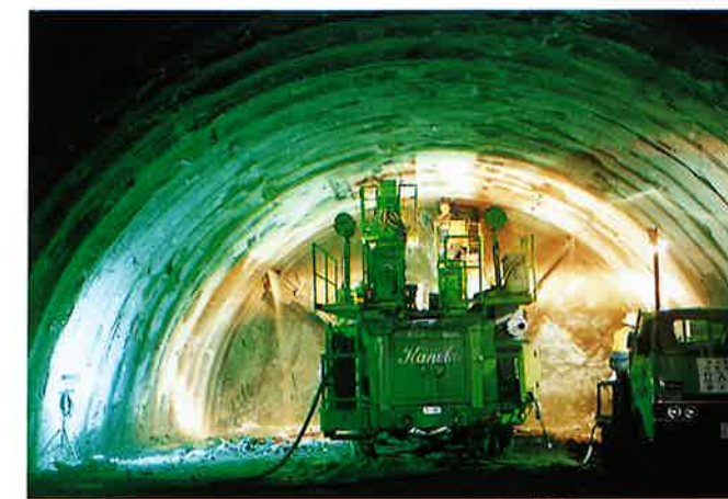
写9. ロックボルトせん孔状況
