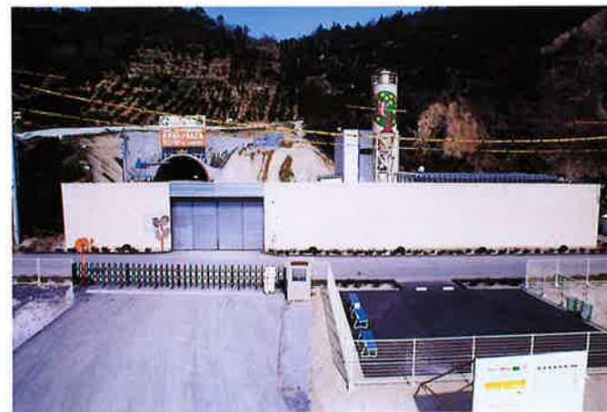
写4. 防音壁 (H=400×400砂充填式)
