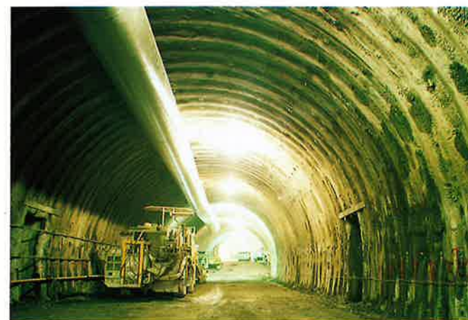
写8. 上・下半掘削完了全景
