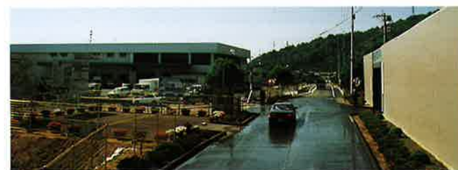
写6. ステーション (現場) 入口
