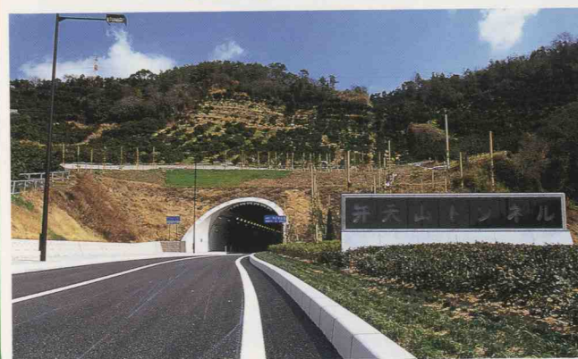
弁天山トンネル 北吉田側坑口(空港側)
