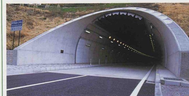
トンネル設備
