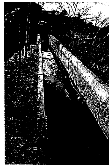
銅山川疏水幹線水路
