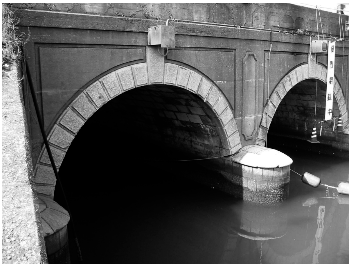
榎瀬江湖川樋門
