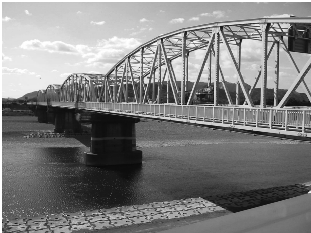
那賀川橋（阿南市）
