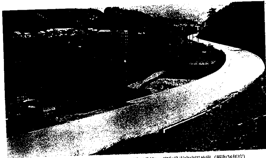
舗装新設工事、二級国道松山高知線（一級国道56号線）宇和島市宇和川地内（昭和36年度）
