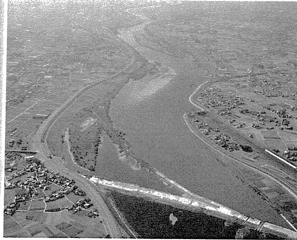
写真17 第十堰（空中写真） 今から約240年前に築造された、上下2段形式の斜め固定堰である。洪水疎通の阻害、老朽化の進行等、治水上の問題があり、可動堰に改築予定。
