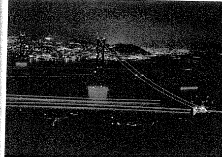
写真20 ケーブル工事中の明石海峡大橋の夜景 (淡路島側から)
