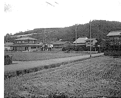
写真16 揺き寄せ堤の跡 宝暦年間に庄屋、稲垣監物が築造したと伝えられる「監物堤」。現在その後をとどめていない。(写真の道路部分)
