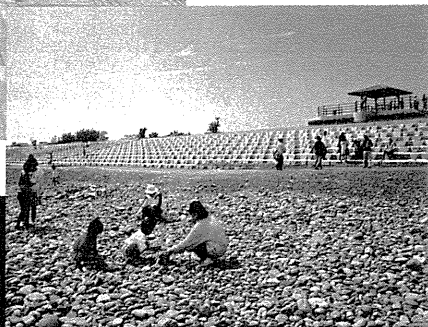
写真43 緩傾斜堤とリフレッシュしたなぎさ
