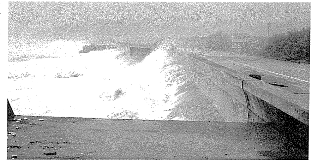
写真40 越波状況(汀線の後退が打ち上げ高を増大させている。)
