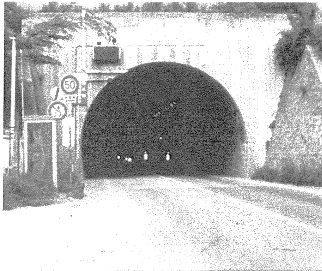
写真36 猪の鼻トンネル
