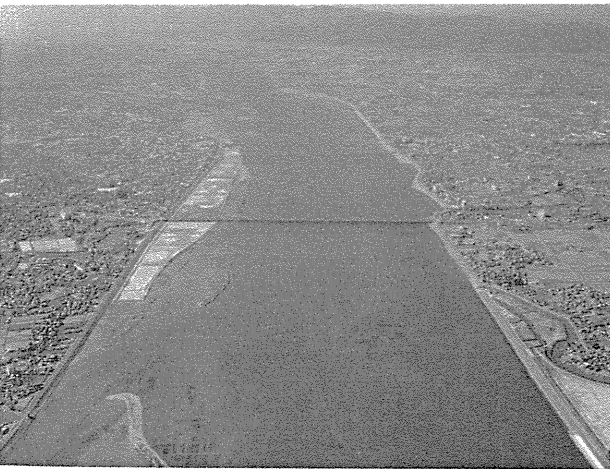
写真19 第十壩門 吉野川本川（現在の旧吉野川）を締め切り、 平水時のみ水を流すため大正12年に建設された。
