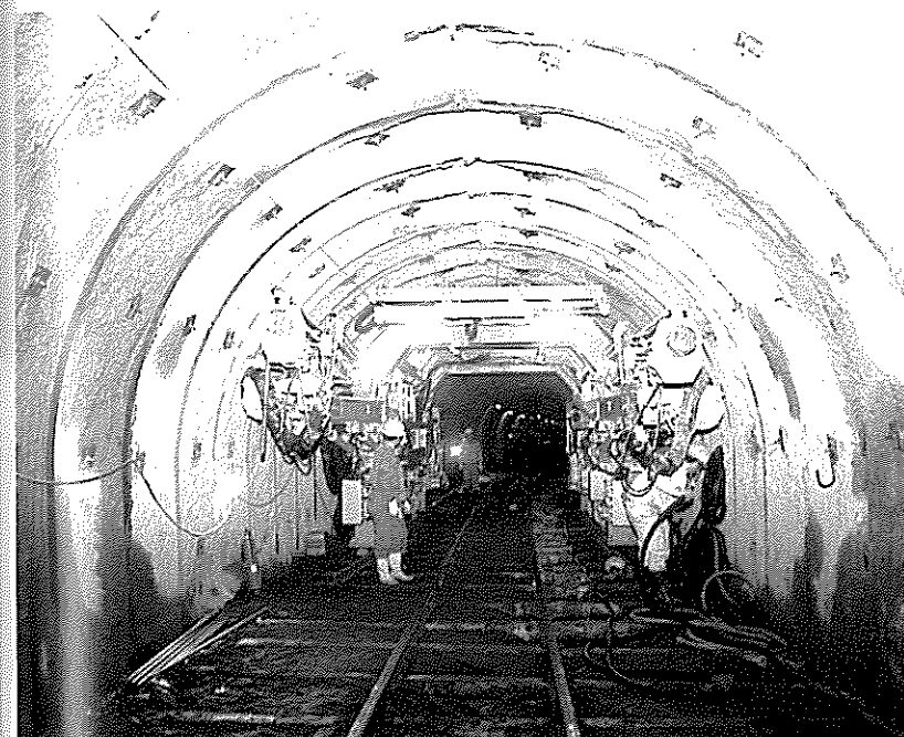
昭和63年10月、愛媛県側から寒風山トンネル掘削開始。本坑に先立ち、作業坑を掘削。この作業坑はトンネル完成後、トンネル内の事故や火災時の避難用通路として利用される
