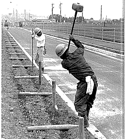
植樹のための工事も始まり、開通間近(高知市大津～介良間、昭和60年)
