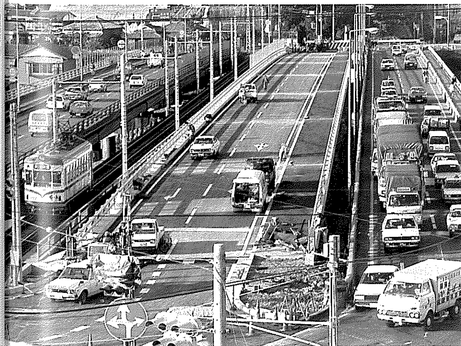
開通直前の鏡川橋（中央）。左が昭和48年に建設された東行きの新鏡川橋、右が旧橋（昭和55年12月）*
