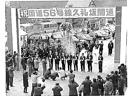
久礼坂改良により新ルートが開通(昭和45年12月) *
