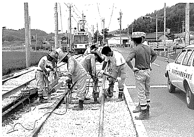
土電電車軌道との交差部分の仕上げ作業(高知市大津、昭和60年)
