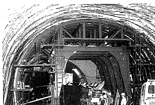
防水シート設置
