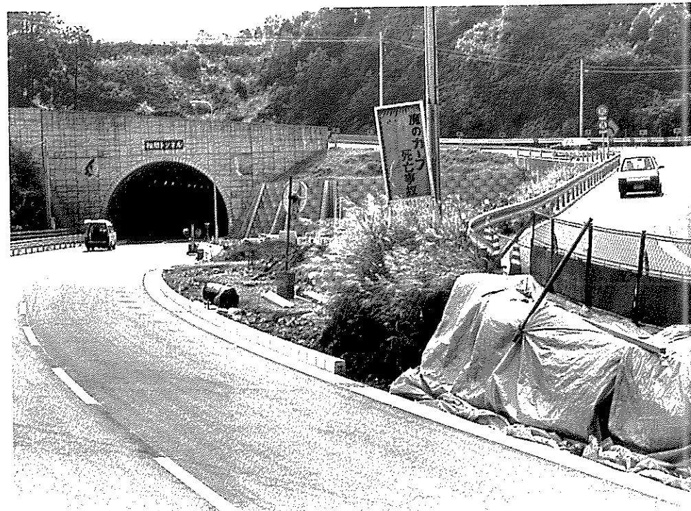
開通間近の新道(平成5年10月)
