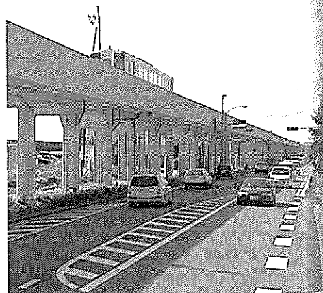
以前は土佐電鉄の軌道だった上部に、いまは土佐くろしお鉄道の線路 (高架) が走る (平成15年)
