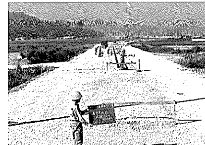
改良工事着工前の高知市高須地区(昭和47年)
