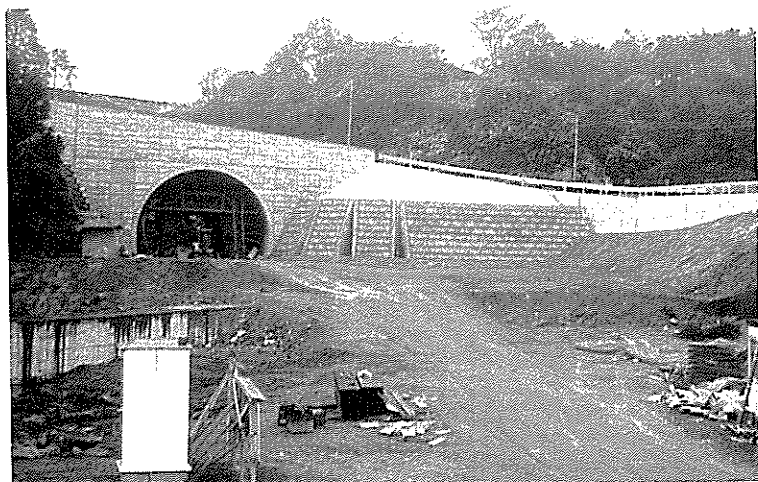
開削が進む相間トンネル北坑口(平成4年)
