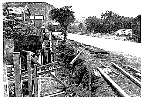
黒耳局改(室戸市吉良川町傍土一平尾)工事(昭和57年) *
