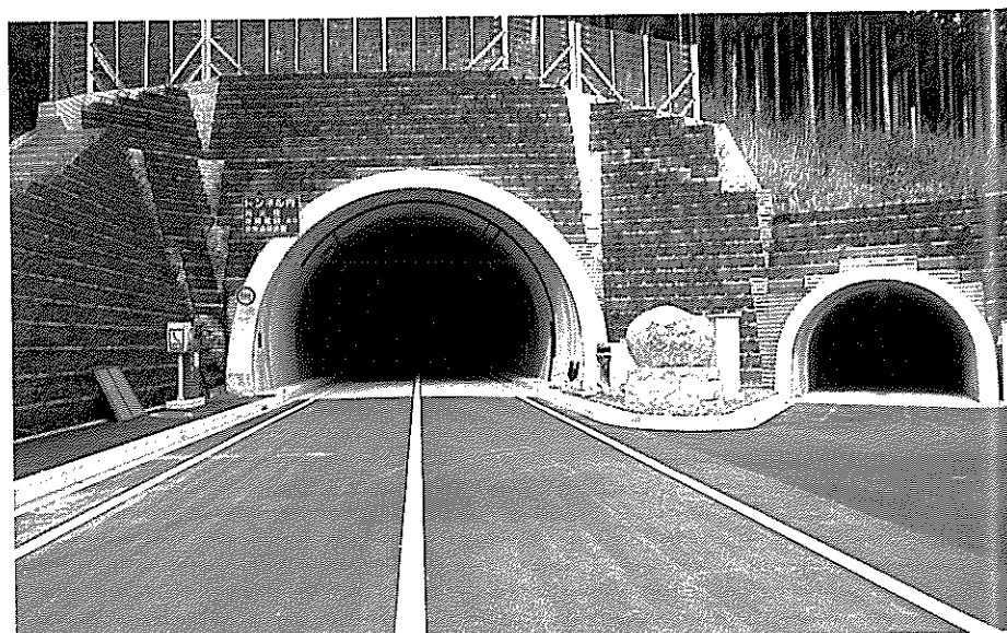
完成した寒風山トンネル(高知県側)
