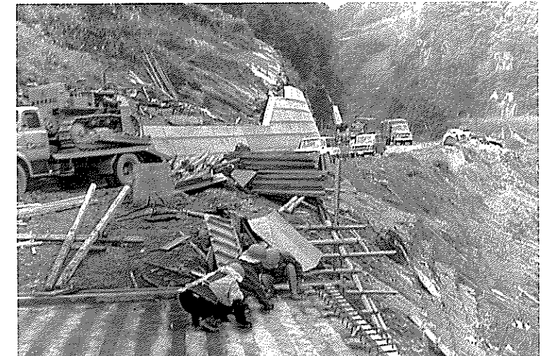
軟弱な地盤を克服しながらの改良工事(長岡郡大豊町大久保、昭和42年) *
