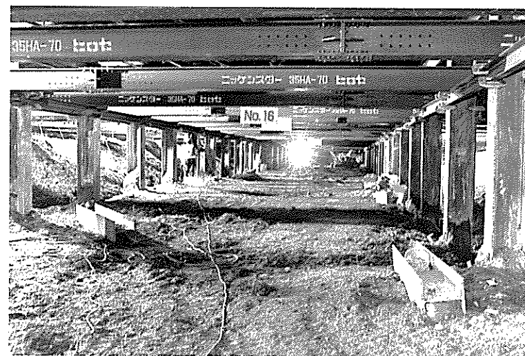
終電後に電車軌道の下を掘り進む(平成8年)
