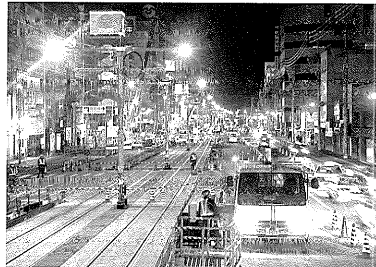
はりまや地下駐車場建設工事(平成8年)
