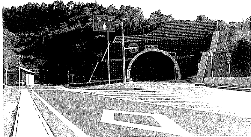
供用開始された手結山第二トンネル・高知側坑口(香美郡夜須町手結山、昭和54年)
