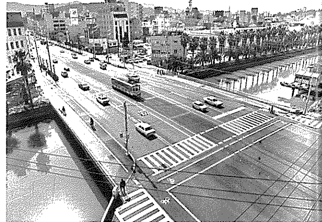
架替が完了した高知橋(昭和56年2月)
