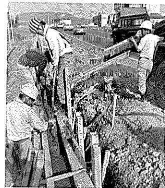
自転車・歩行者用道路の 設置工事(昭和54年)
