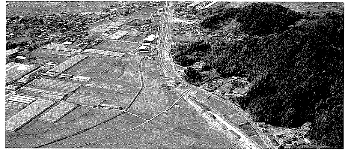
整備が進む春野拡幅(平成6年)
