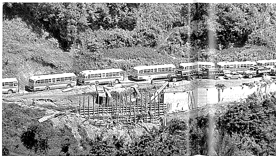
混雑する国道工事現場(昭和40年)
