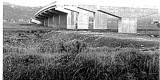
小籠側道橋を架設(昭和56年)
