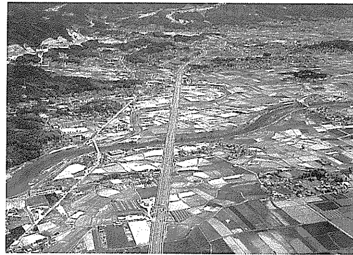
完成した高知東道路(平成3年)
