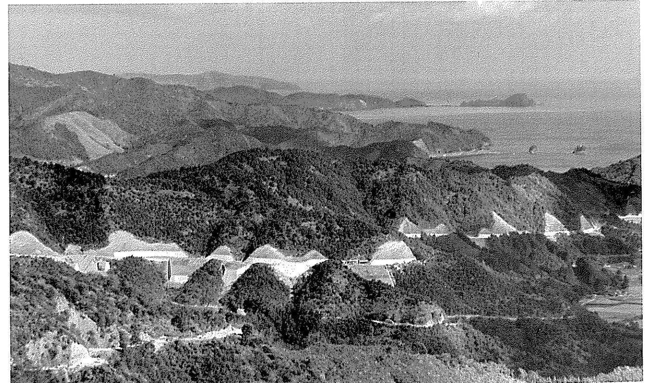
改良工事が進行する久礼坂(昭和45年) *
