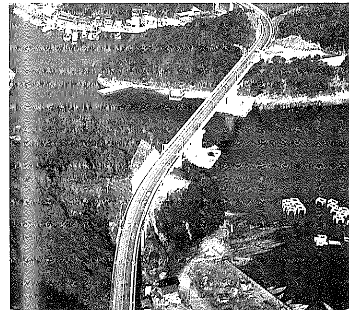
安芸郡東洋町甲浦地区の改築が完了(昭和48年) *
