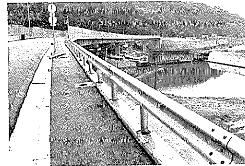
完成した加領郷大橋(昭和48年10月) *
