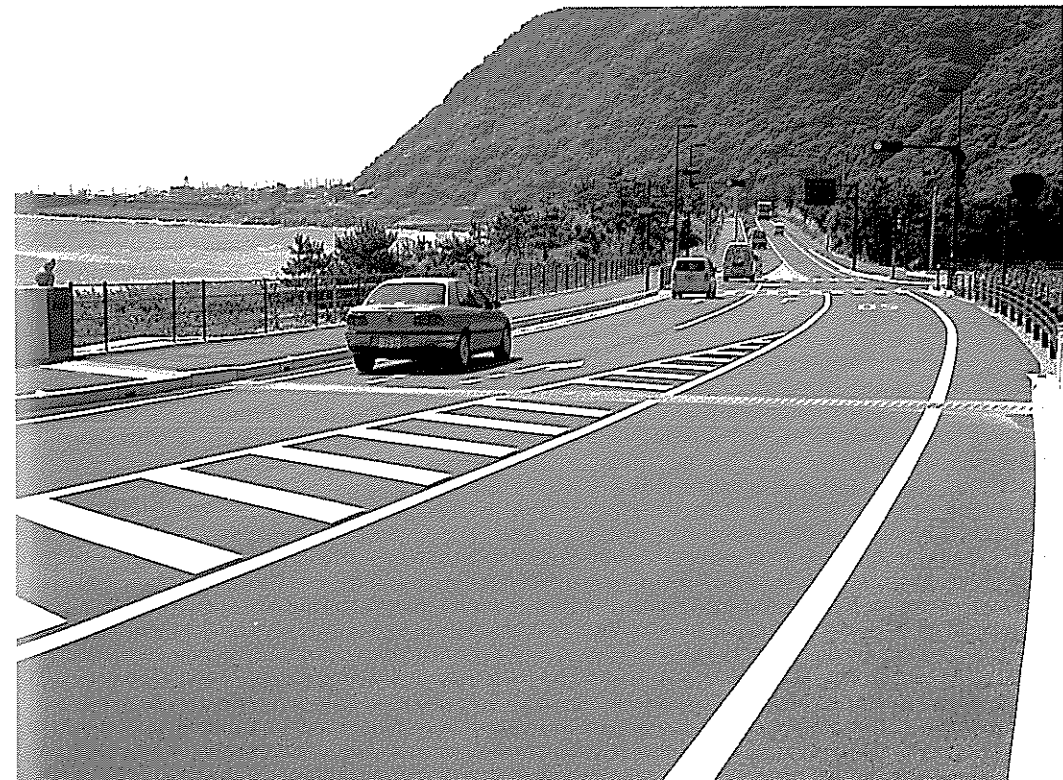
バイパス(元海岸道路)が完成(平成14年7月)
