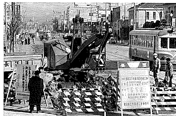
舗装工事中の国道(高知市大橋通り一升形間、昭和38年) *
