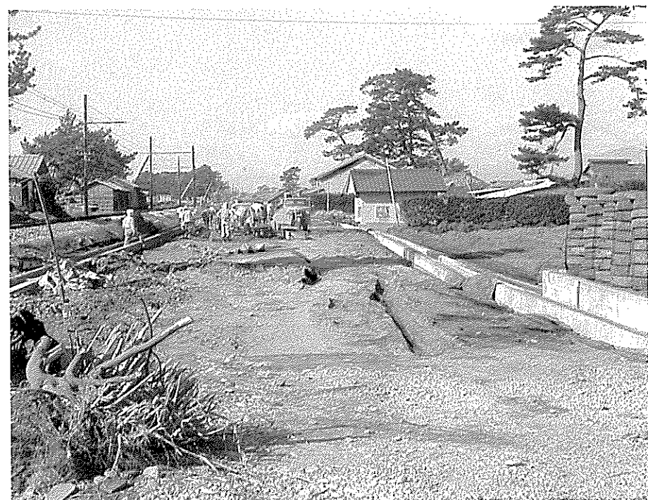
月見山一堀川橋間の道路工事 (昭和37年) *
