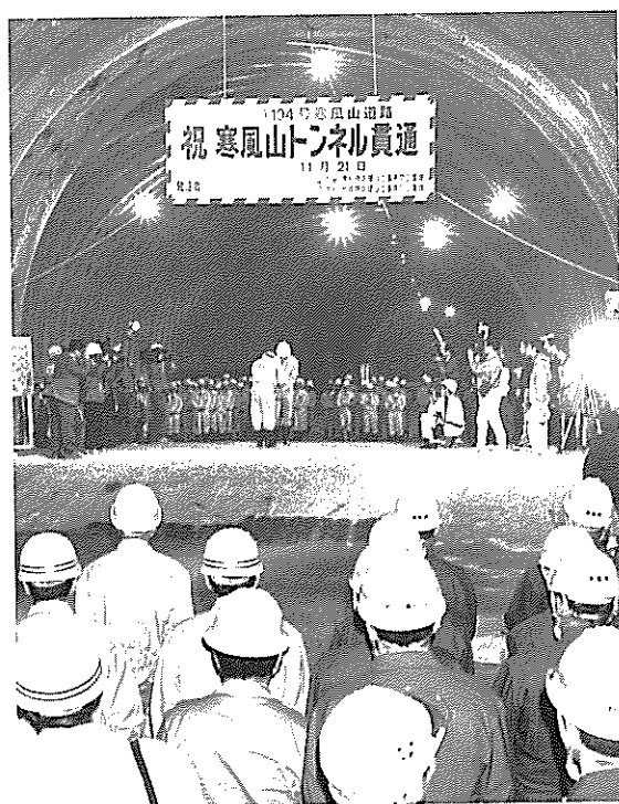
寒風山トンネル貫通式(平成8年11月) *
