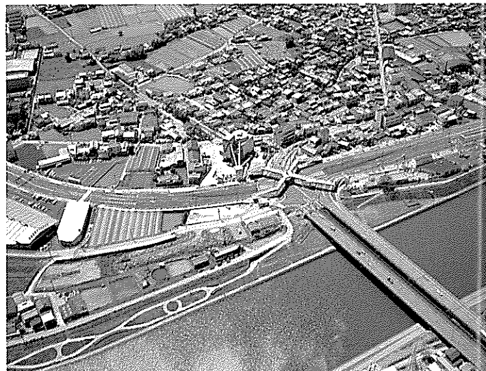
平成3年に完成した高知市鴨部立体交差
