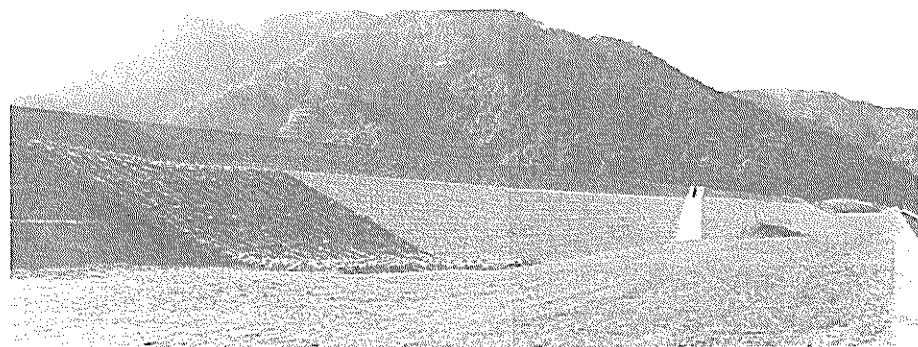
S54年度入田護岸工事
