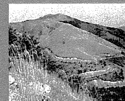
安全改良を目的に地方道路の建設が進んでいる。
