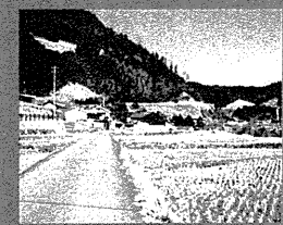
片坂改良/旧道から第2市野瀬橋付近を見る
