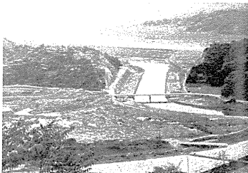
甲ヶ峯開削により現在と同じ流れに変わった中筋川
