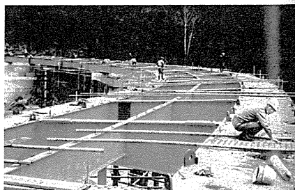
第2市野瀬橋の工事(3径間連続曲線鋼箱桁)
