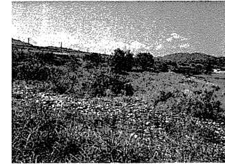
【完成後】覆土に河床材を使用した結果、植生が繁茂し、水辺の緑が形成されていた。
