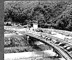
伊与喜局改/濁室橋
