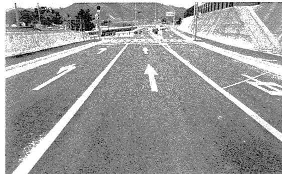
窪川トンネル東詰から高知方面を見る。
