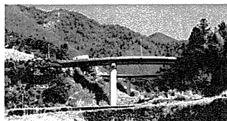
2つの橋がヘアピンカーブをつくる。橋脚は中空張出式。
