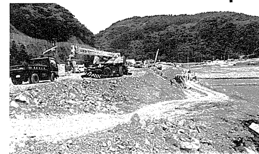
中角地区改良工事状況
