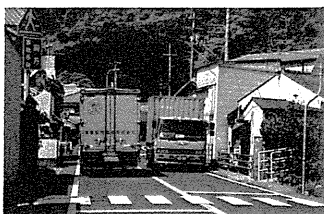
線形が悪く歩道もないため、大型車の行き違い時は危険がともなう。最小半径=50m、最小幅員=7.0m、区間歩道整備率52%
