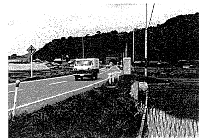
新道/田圃地帯を貫通し、見通しも良い。向こうは伊田トンネル
