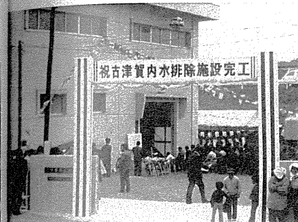
昭和49年4月2日 古津賀排水機場竣功。昭和20年に樋門を設置していたが、老朽化のため昭和46年から改築工事を行った。
