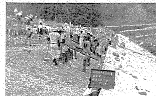
昭和38年8月 不眠不休で復旧工事が行われた。
