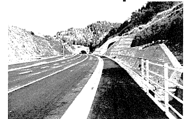
窪川トンネル/上り側には追越車線を整備。
