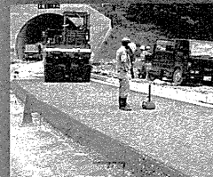
布施ヶ坂工区/工事もいよいよ大詰め
