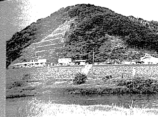
【完成後】地上げ盛土施工で、安全性を確保。自然植生が繁茂し河川景観も向上した。
