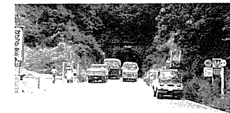
旧道・呼坂トンネル/L=152m、W=5.5mのこのトンネルは昭和5年施工。残念ながら時代にならなくなってしまった。
