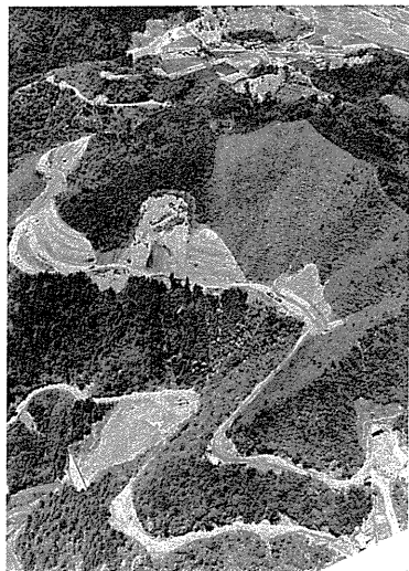
昭和45年5月 トンネルをめき、山はだを削り、姿を見せ始めた片坂改良
