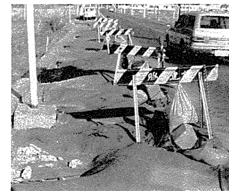
旧道/歩道の整備もされておらず、危険。
