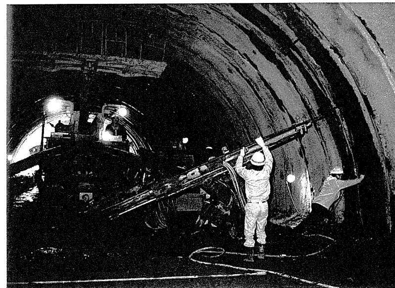
NATM工法による布施ヶ坂トンネルの工事
