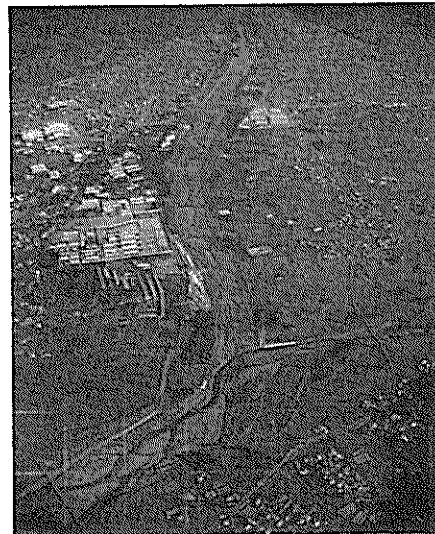
重信川砂防は道後平野を直下流に控え流域砂防の重要性は大きい(表川合流点付近)
