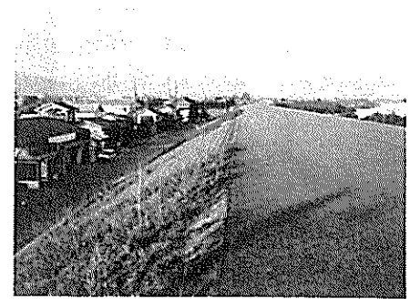
岩津嶽前部の波浪対策として3面張堤防として概成した西林地防
