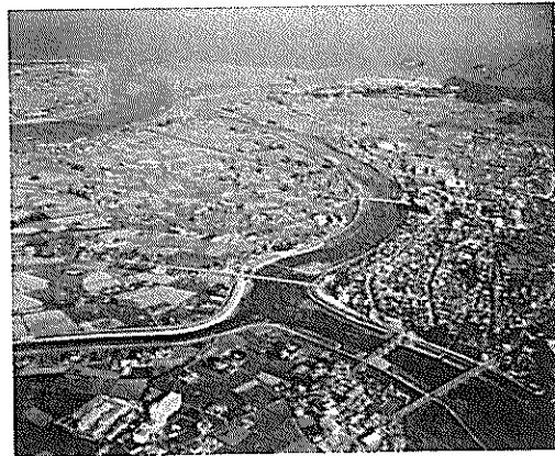
昭和30年頃はほとんど無堤地帯であった桑野川下流部もいまでは水害の慘禍から解放された
