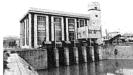
管内最大（30m 3 /S）の排水量を持ち、伊野町の内水被害を防ぐ宇治川排水機場
