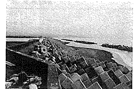
49年の台風による破堤箇所は翌年その復旧を終え離岸堤防群の建設も加わって万全の備えが整った。
