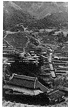
堰堤建設と併行して整備される流路工（表川支川高智谷）
