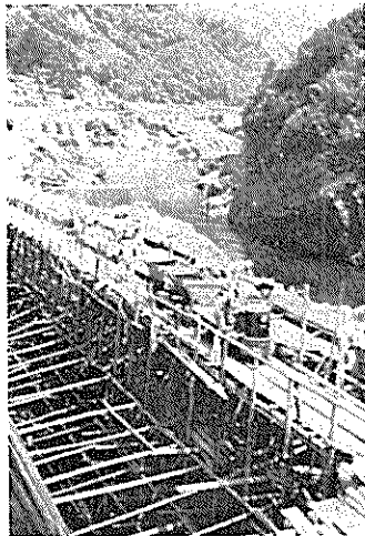
写真3-3-2 32号川口改良コンクリート打設
