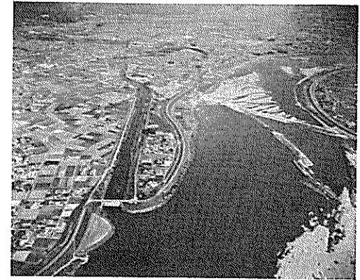
宝暦2年の築造以来旧吉野川沿川の利水、治水を支えてきた第十堰
