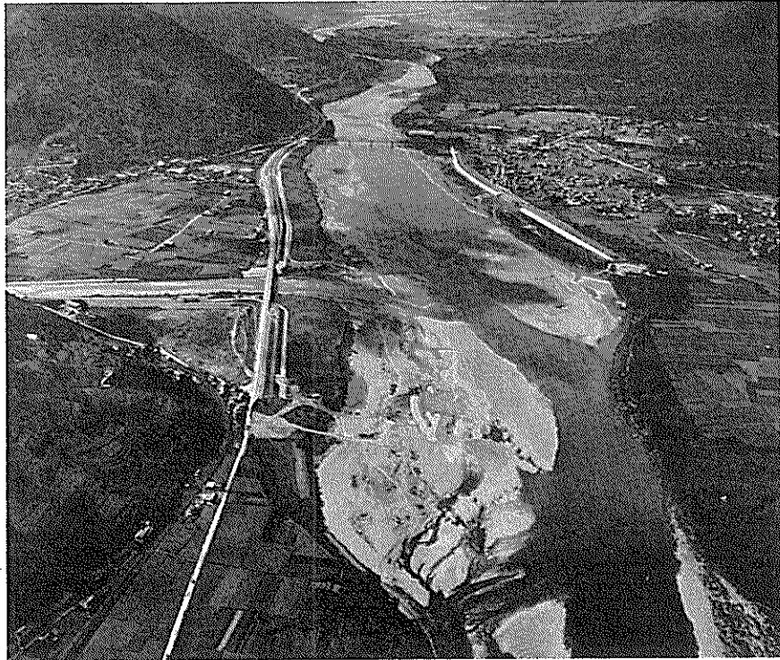
国道192号線の改築と併せて改修を急いだ真光堤防
