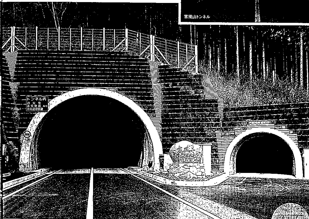
高知県側 坑口
