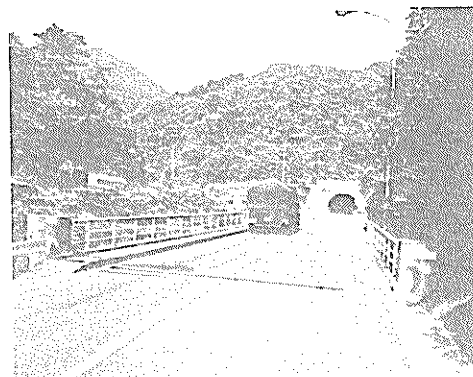
◦ 境目トンネル
