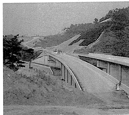
土工工事（額坂高架橋付近）
