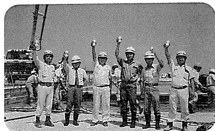
区間最後の橋りょう床版打設が完了した豊浜高架橋
