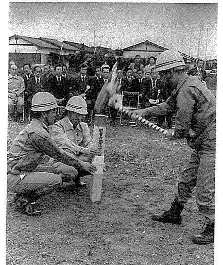
測量調査に備えての中心杭打ち式＝昭和56年10月30日
