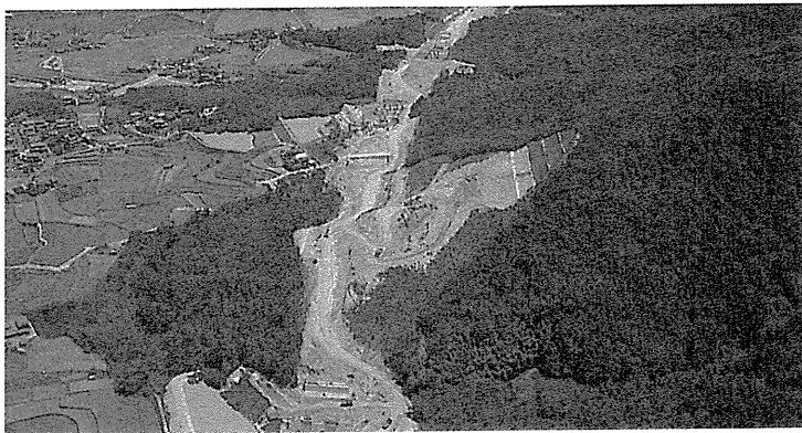
土工工事（国分寺地区）
