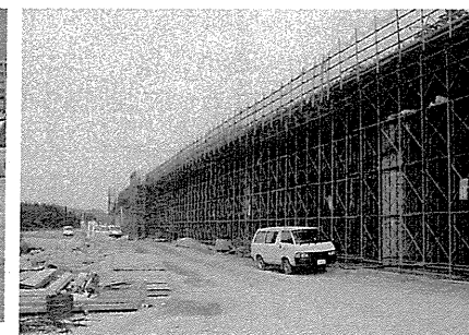
足場が組まれた工事現場(白鳥町付近)
