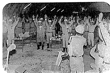
鳥越トンネル貫通式＝昭和61年6月
