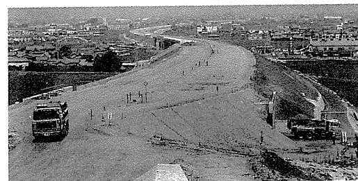
工事が急ピッチで行われる善通寺市吉原町付近 ＝昭和61年8月12日
