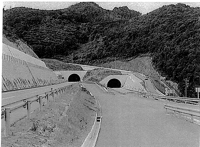
鳥越トンネル高松側坑口
