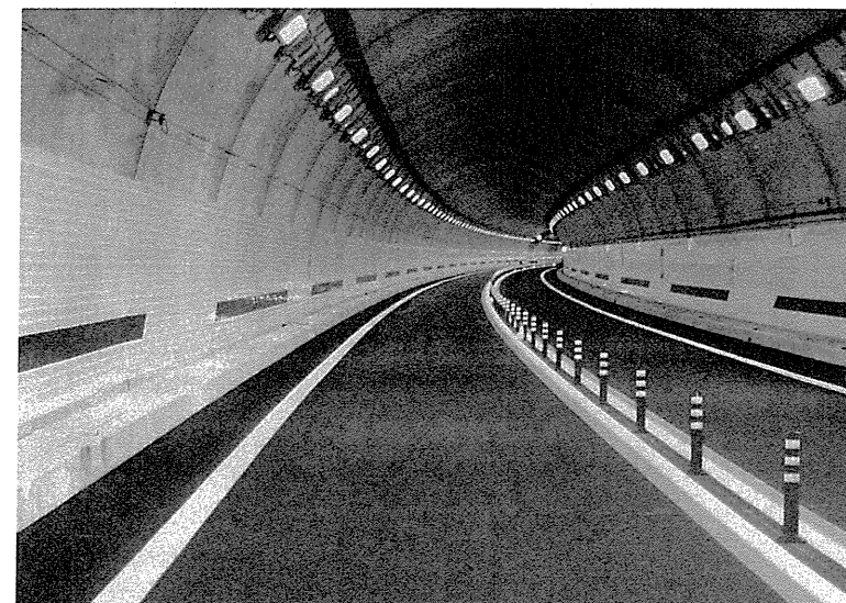
明るく走りやすい大坂トンネル
