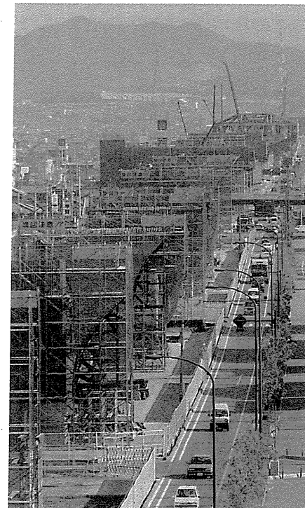
高松市内の工事＝平成11年2月12日
