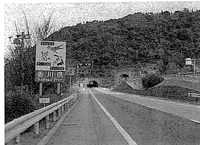
鳥越トンネル高松側坑口付近
