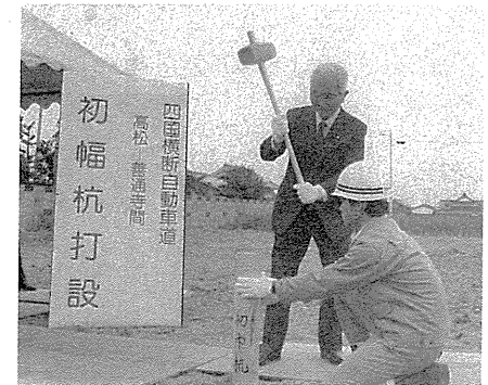
初の幅杭を打ち込む堀家丸亀市長＝昭和62年5月11日
