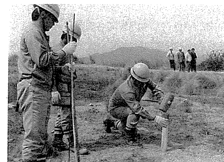
中心杭を設置する工事関係者（志度町志度南ニュータウン）＝昭和63年4月14日
