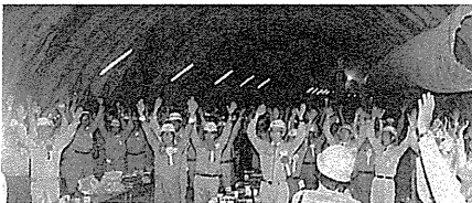
鳥越トンネル貫通式＝昭和61年6月
