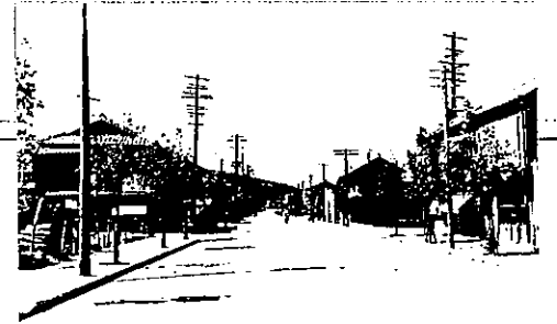
塩上橋より西側は高松市の街路事業で改良を行った。
