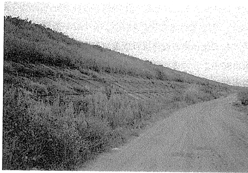
中須賀漏水対策
