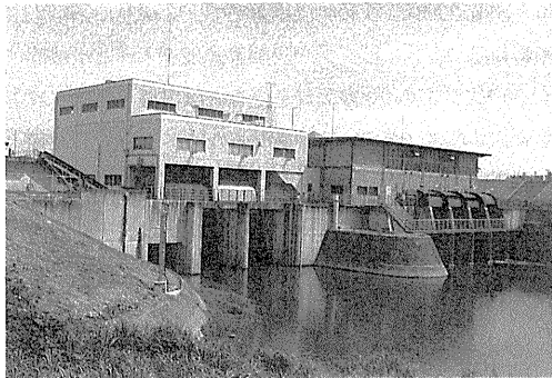
新飯尾川排水機場・飯尾川排水機場
