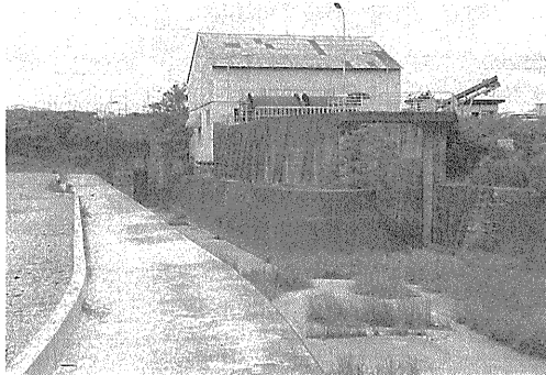
川島排水機場
