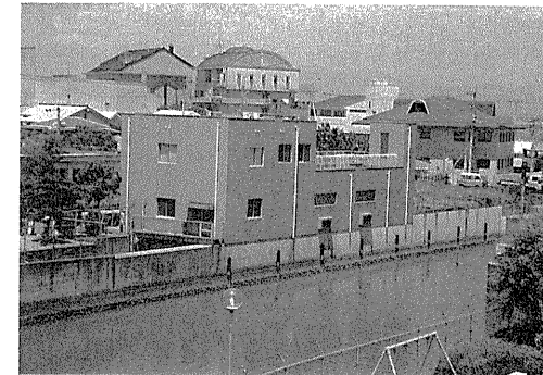
新町川浄化ポンプ場
