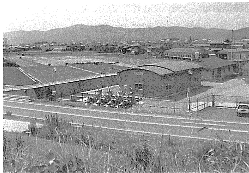
前川排水機場（救急内水）
