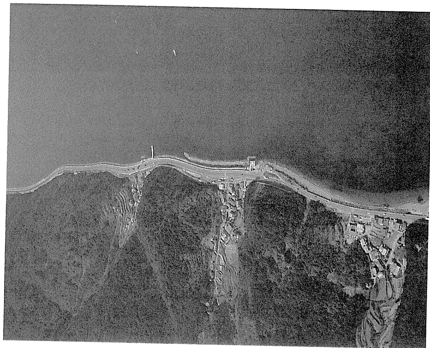
折野地区の完成供用状況
