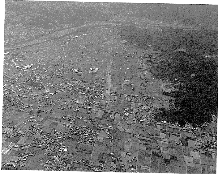
改良工事が進む徳島南環状道路（H 9. 撮影）
