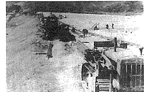
写4-2-1 直轄改修着手と同時に導入されたブルドーザーによる汽関車軌道敷設状況
