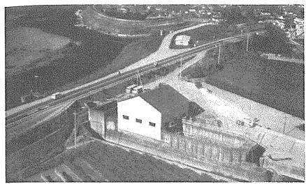
川島排水機場: ポンプ容量12㎡/s。昭和39年完成。吉野川で最初の設備。
