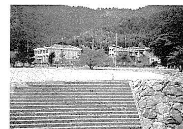
■環境整備事業工事(平野地区)
