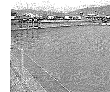
工業用水配水池(調整池)
