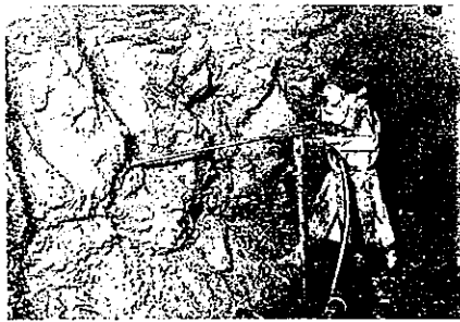
銅山川分水隧道工事
