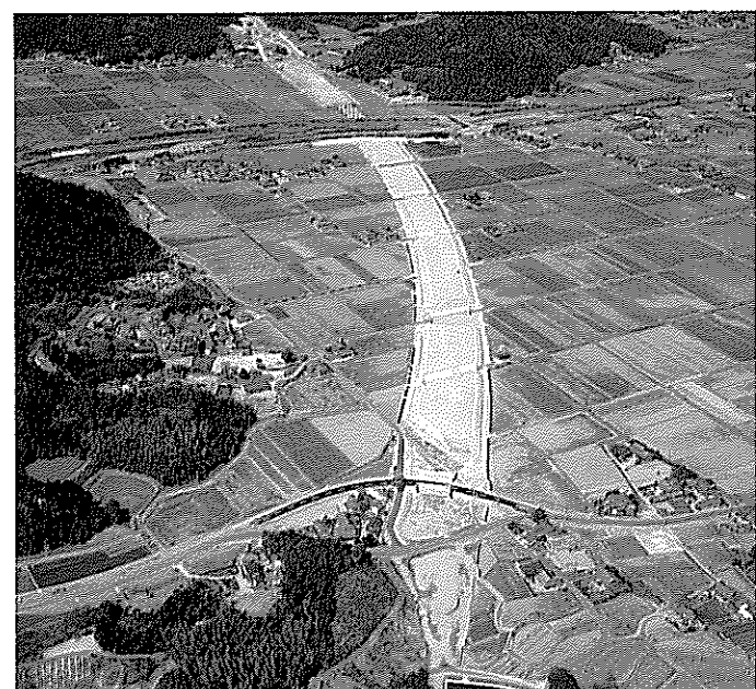
建設中の11号高松東道路(志度町鞆部付近)
