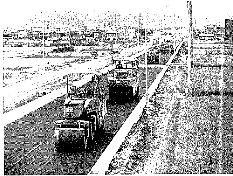
昭和44年12月開通に向け、舗装工事も急ピッチで進む
