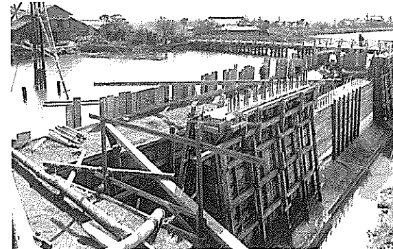
本橋は昭和11年3月に完成した。架橋にあたっては、人、馬、車等の足を確保するため仮橋を設けた。
