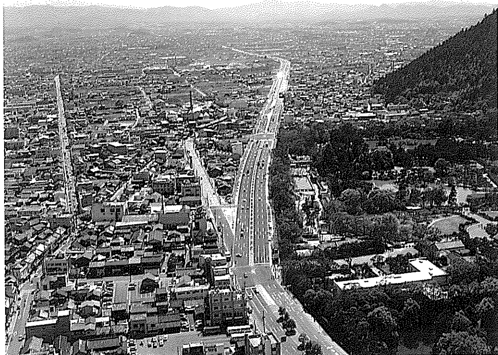
高松南バイパス全線開通（高松市栗林町～坂出市府中町間）。栗林町より南を望む（昭和50年4月9日）
