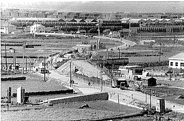
昭和39年宇多津跨線橋の建設に着手
