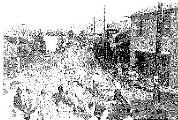
津田町内のアスファルト舗装工事（ソイルセメント路盤の施工）（昭和34年）
