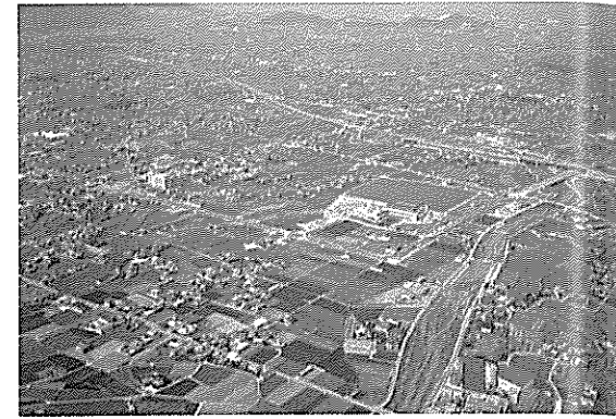
319号善通寺バイパス、開通。善通寺市与北町より望む (平成4年3月)
