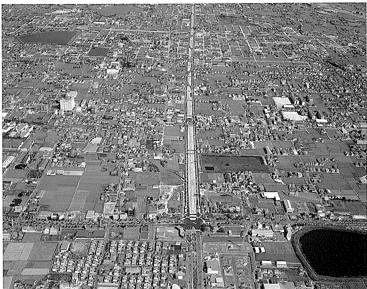
平成5年9月3日高松市上天神～県道高松長尾大内線間、延長5.6km。6車線の内暫定で2車線供用
