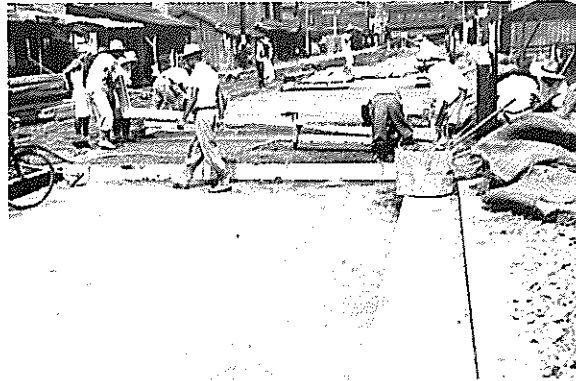
当時のコンクリート舗装工事(昭和29年)
