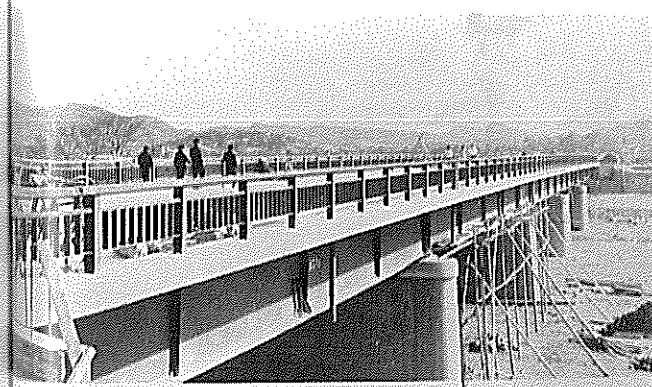
完成した11号湊川橋（大川郡白鳥町）（昭和36年2月19日）
