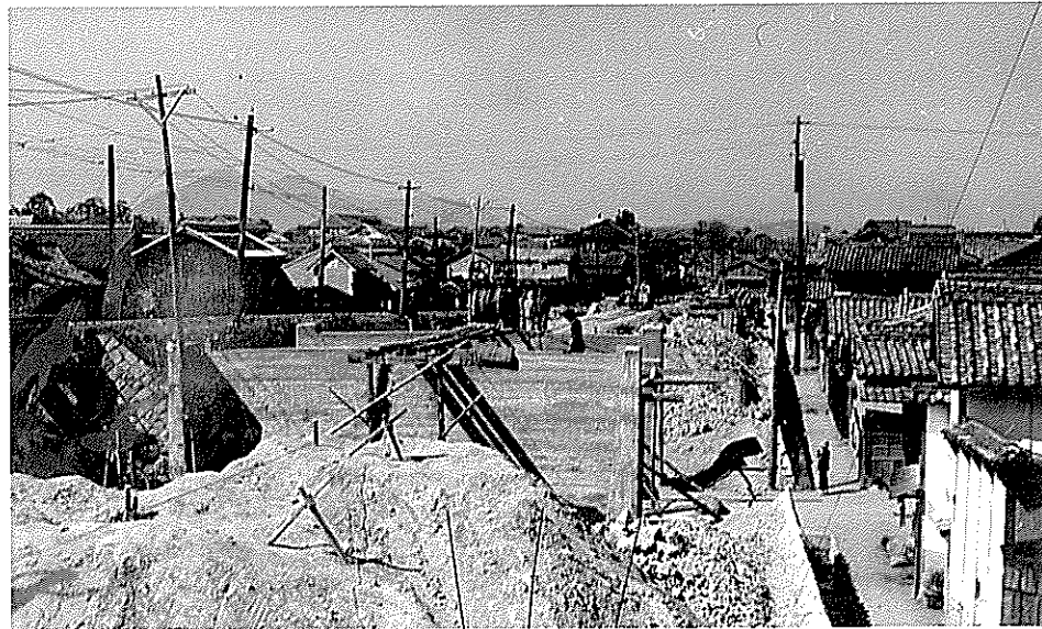
丸亀市都市計画街路土居土器内間線のうち土器川左岸側を23号として改良工事を行った。 〈昭和22年〉
