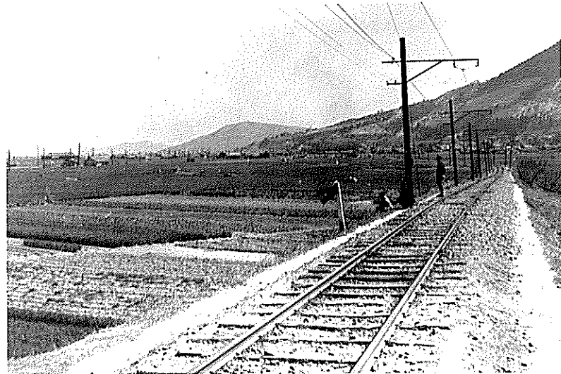
予讃線より23号改良箇所を望む(土器村内)〈昭和21年〉
