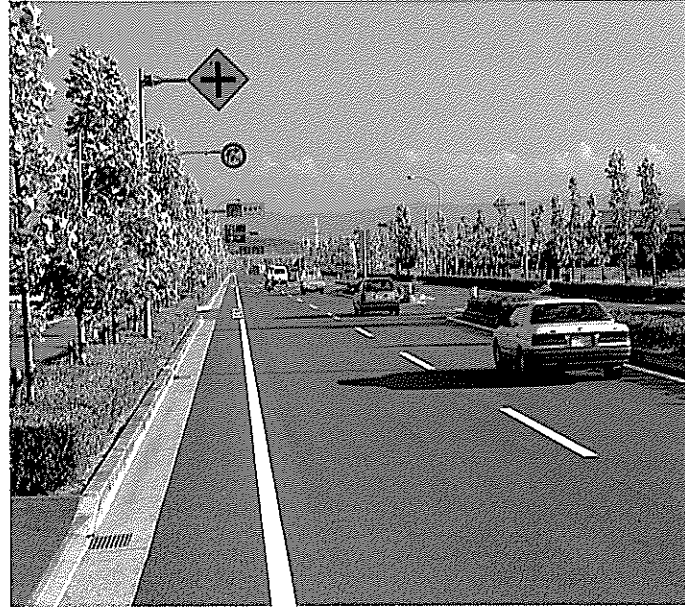
319号善通寺バイパス、開通(善通寺市原田町)(昭和62年12月) (平成6年撮影)
