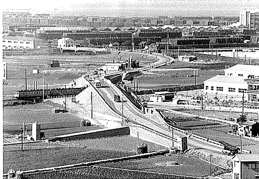
昭和40年2月1日宇多津跨線橋が完成
