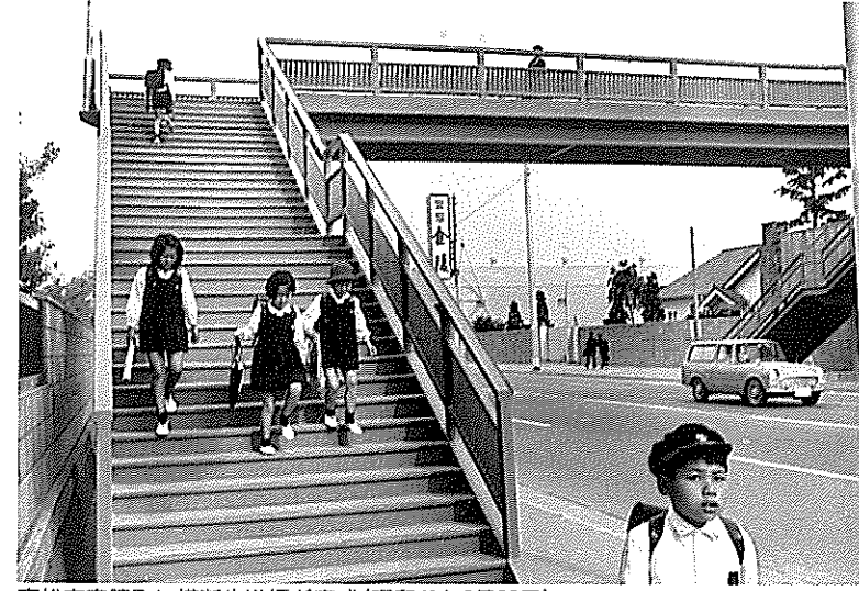
高松市宮脇町に横断歩道橋が完成（昭和41年3月26日） （提供／四国新聞社）
