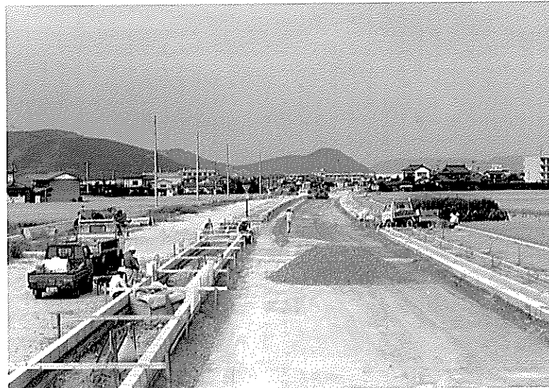
建設中の32号円座バイパス(高松市西山崎町)(昭和59年)
