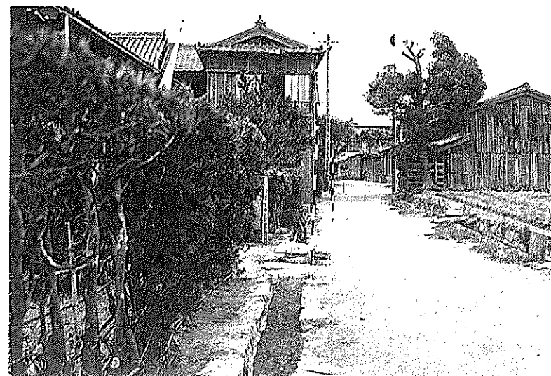
宇多津町内の拡幅現場（昭和15年）
