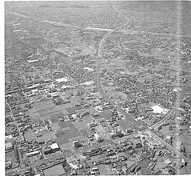
32号円座バイパス全線供用(平成2年3月)
