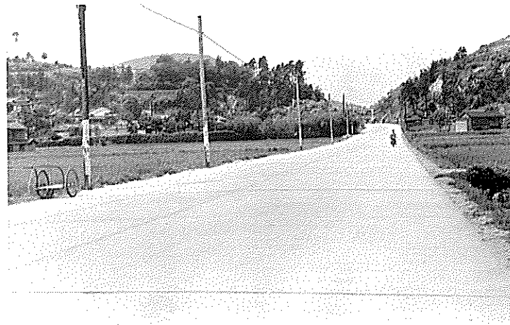
完成した坂出市田尾坂のコンクリート舗装(昭和30年)
