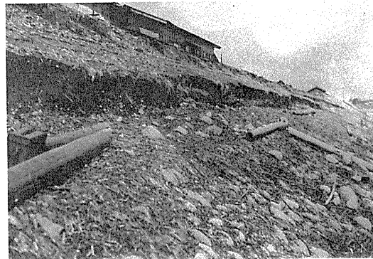
岩脇地先の新堤崩壊状況
