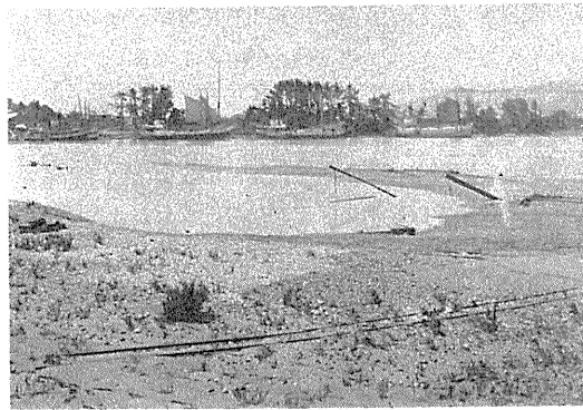
富岡水門の被害状況
