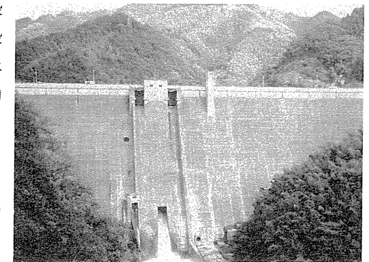
写真3-3-4 慢性的な水不足に悩む松山地域の救世主として建設された石手川ダム(昭和48年3月完成)
