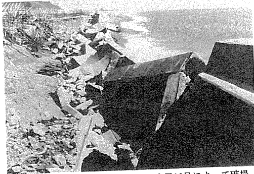
写真3-5-3 昭和54年9月の台風16号によって破堤した仁井田地先の海岸堤防
