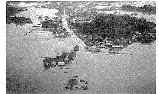
写真3-2-4 昭和50年台風5号出水により波介川は全川的に氾濫し、土佐市中心街は泥の海と化した
