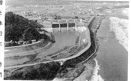
写真3-2-58 管内最大のゲート高さ（12m）を誇る波介川水門（右側は仁淀川本川）
