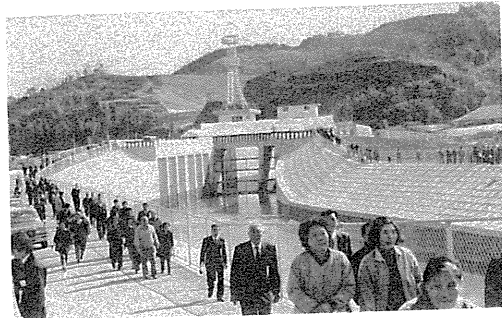
写真3-2-54 待望の日下川放水路の通水式風景
