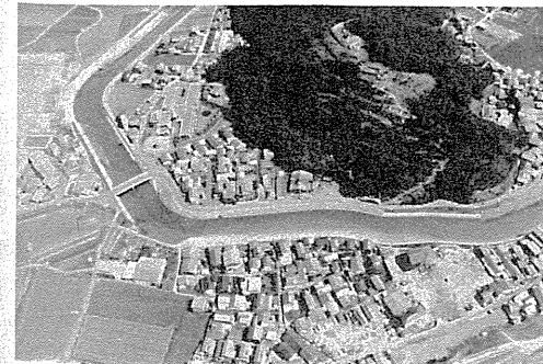
写真3-2-56 激時事業により河道の疎通能力が向上になった宇治川天神地区
