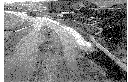
写真3-2-36 改修方式について多年の懸案であった耳切地区は河川、道路、土地開発の三者合併により完成が間近い
