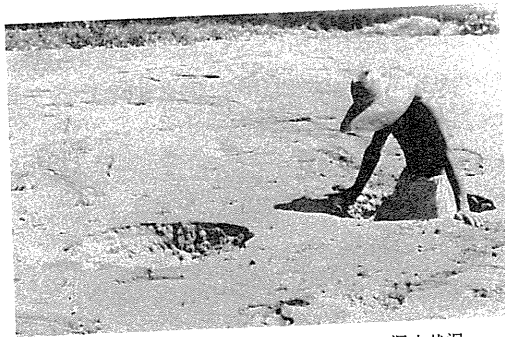
写真3-2-8 昭和29年9月出水による漏水状況
