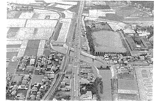
写真3-2-29 慢性的な宇治川氾濫解消のため激特事業の後を受けて、国道等の南側に付替え完了した宇治川新河道
