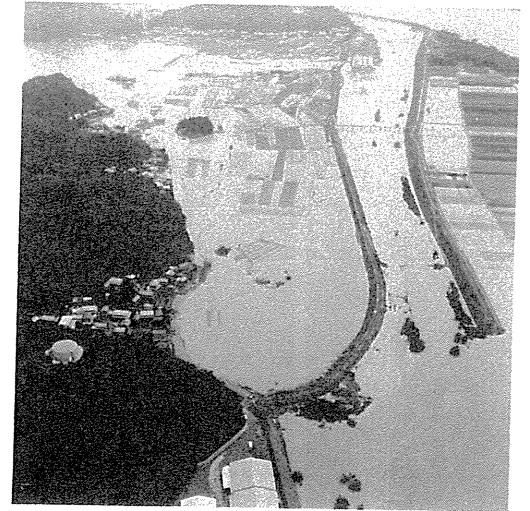
写真3-2-25 波介川合流点直上流の用石堤防は昭和50年5号台風出水により破堤した
