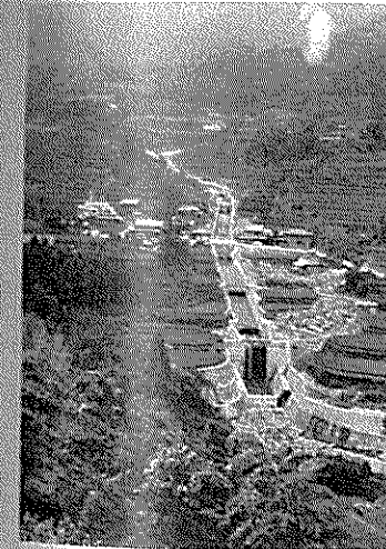
高知谷流路工 （井内川支川高知谷川）
