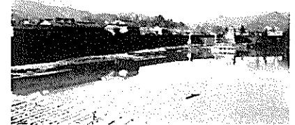
完成した大洲左岸特殊堤
