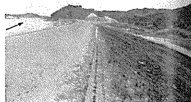
完成した坂本背割堤防。堤頂は道路と兼用され、舗装されている。
