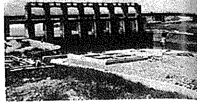
洪水の流下を著しく阻害していた旧一の堰。
