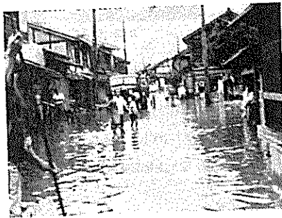
昭和25年9月出水による浸水状況 (大洲市喜多小学校前)
