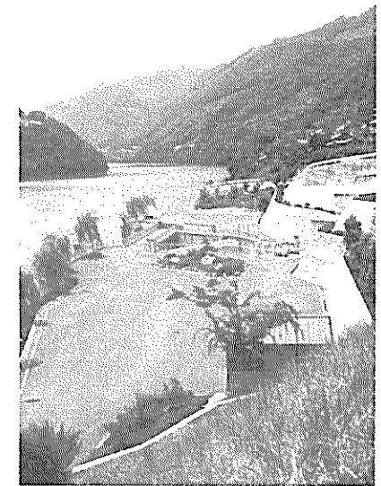
吉野川北岸用水取水口 池田ダム左岸直上流に位置し、かんがい期最大14.8 m 3 /sec非かんがい期2.01 m 3 /secが取水される。
