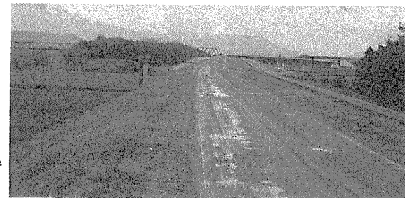
写真 2.4.4 香美無堤部の締切り（吉野川の岩津下流は明治40年に着工して以来86年ぶりに連続堤となった）
