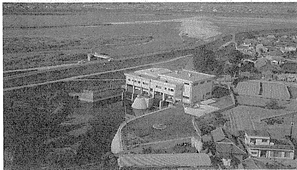
写真 2.4.26 神宮入江川排水機場
