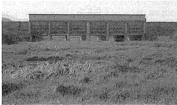
写真 2.4.11 ほたる川樋門
