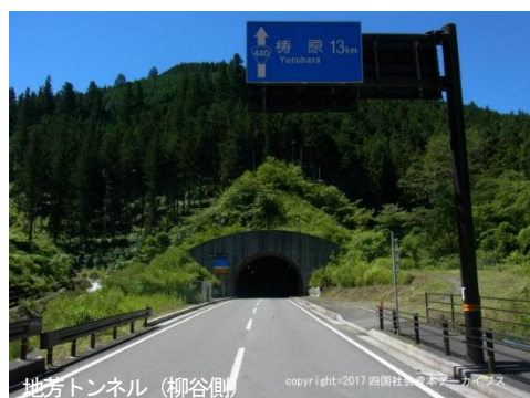
地芳トンネル（柳谷側）
