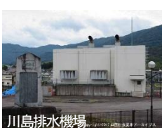
川島排水機場
