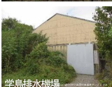
学島排水機場
